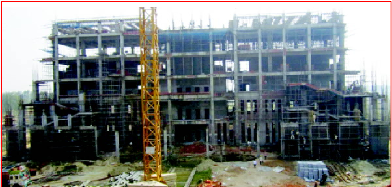
राजीव गांधी पेट्रोलियम प्रौद्योगिकी संस्थान का निर्माणाधीन रायबरेली परिसर
